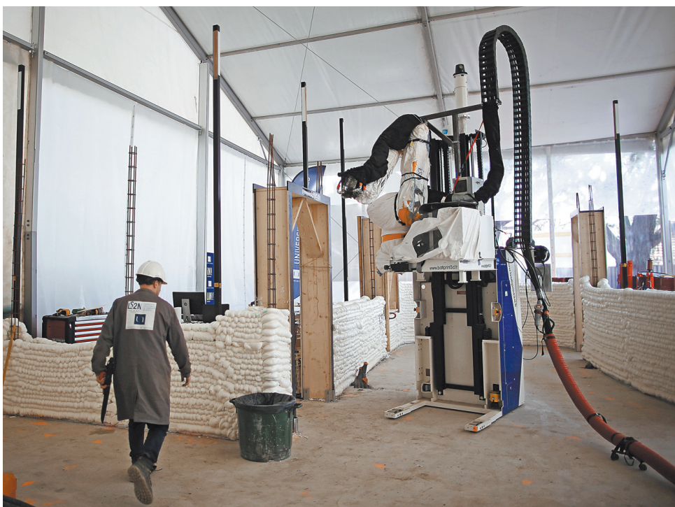
Четырехметровый механический робот способен с помощью системы лазеров выкладывать стены.
