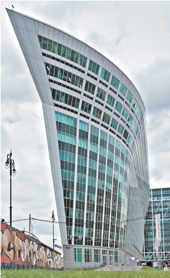
Центр «Китеж» у Киевского вокзала, в мире—«Титаник». Первое в столице здание, расширяющееся вверх с обратным наклоном. Длина—400 метров, высота—50.
