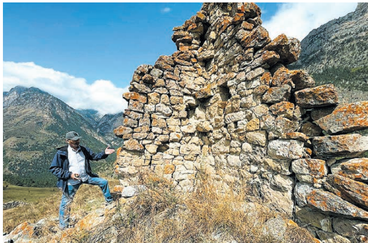
Школа каменщиков-реставраторов «Наследие»
