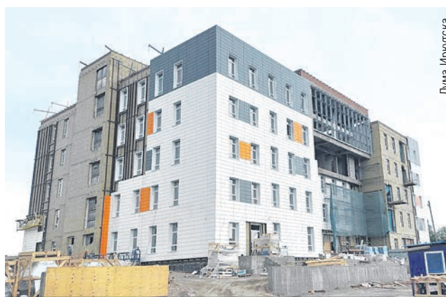
В предместье Рабочее идет строительство поликлиники № 15.
