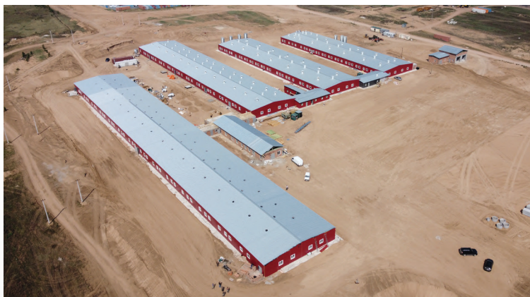
Строительство второй очереди свиноплеменного комплекса «Восточно-Сибирский» («Сибагро») завершено в Республике Бурятия.
