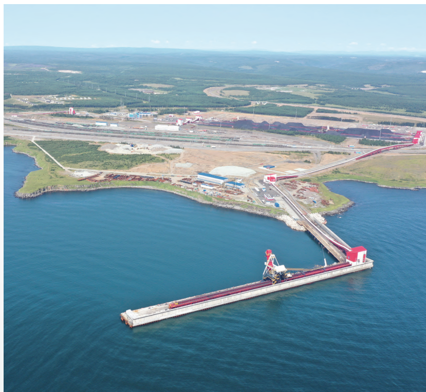
Компания «ВаниноТрансУголь» реализовала первую очередь проекта транспортно-перегрузочного комплекса в порту Ванино в Хабаровском крае.
